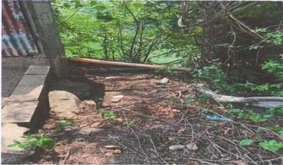
Foto 1: Reparación de Drenaje.
