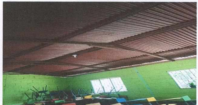
Foto 4: Mantenimiento de pintura en Lámina.
