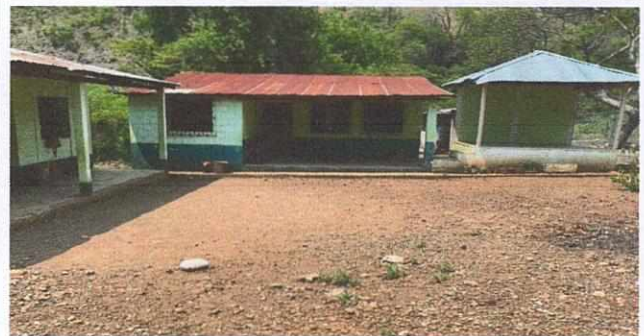
Foto 6: Reparación de Patio y Pavimentado
