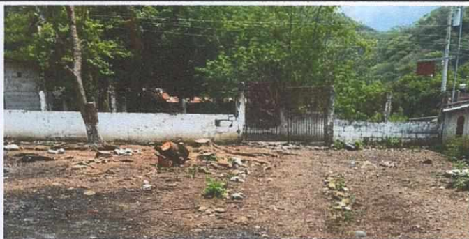
Foto 5: Reparación del Muro Perimetral
