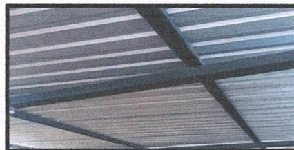
Foto No. 2 Parte del techo de un aula
