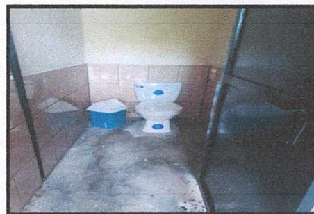
Foto No. 4 Cambio de sanitarios y colocación de azulejo
