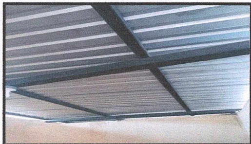
Foto No. 1 Techo en cocina, bodega y ampliación de cocina
