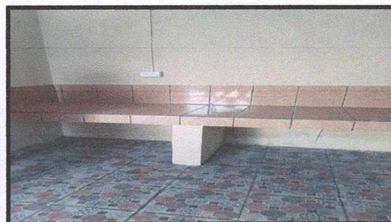
Foto 6. Ampliación y reparación de cocina
