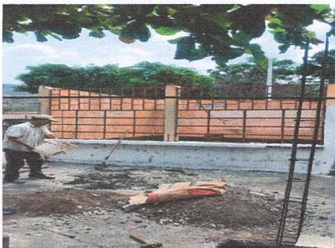
Foto No. 1 Ampliación de cocina
