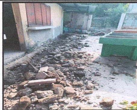
Foto No. 2 Drenaje
