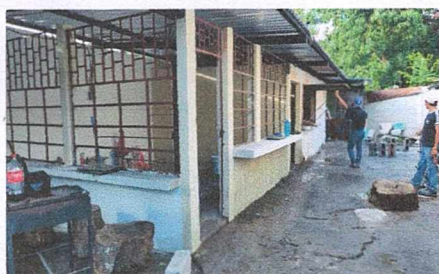
Foto No. 5 Reparación bodega y cocina
