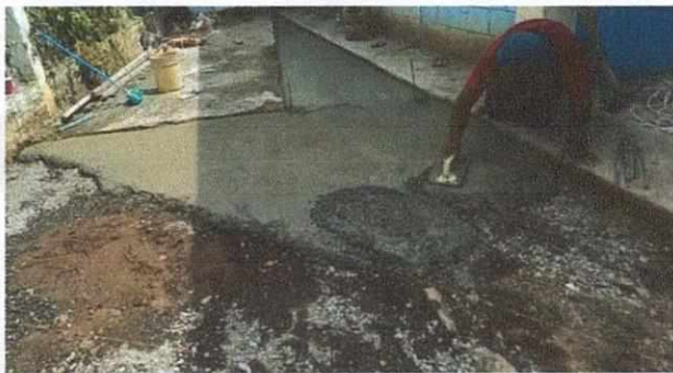
REPARACION DE BAJADA DESFOQUE A PATIO
