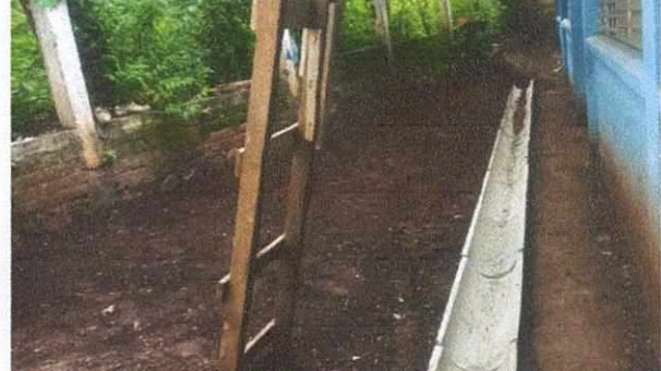
REPARACION DE BAJADA DESFOQUE A PATIO
