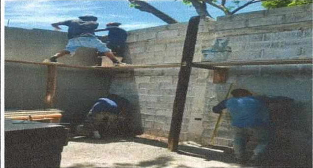
REPARACION DE COCINA
