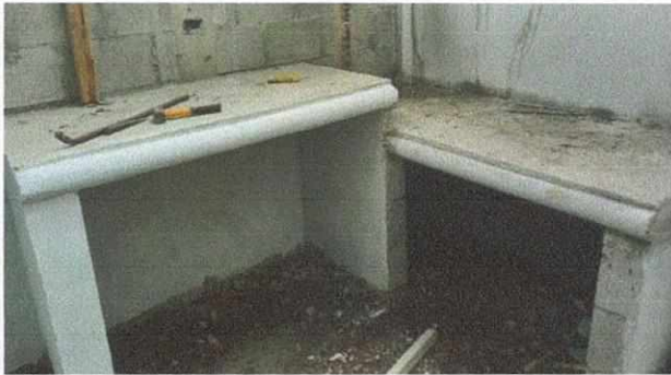
REPARACION DE COCINA
