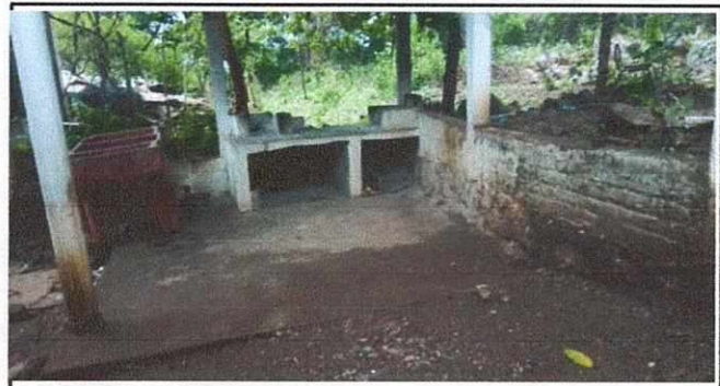
REPARACION DE COCINA
