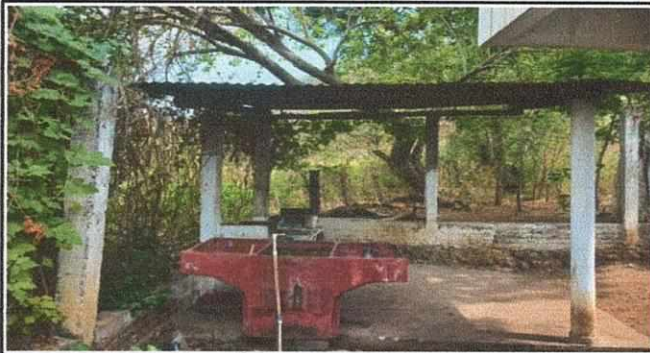
REPARACION DE COCINA
