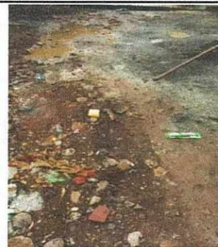
REPARACION DE BAJADA DESFOQUE A PATIO
