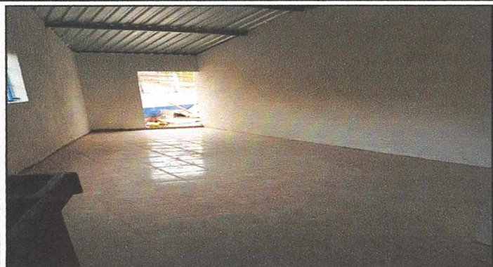
Foto1: cocina con techo de metal repellada y con piso ceramico
