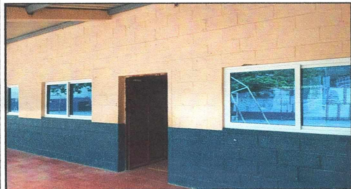
Foto 3: Colocacion de ventanas de PVC.
