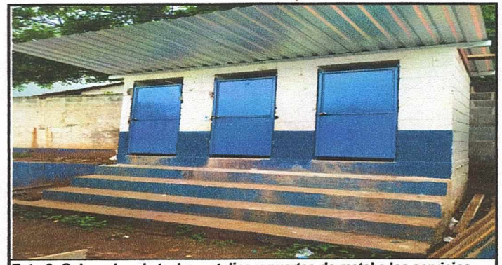
Foto 6: Colocacion de techo metalico y puertas de metal a los servicios sanitarios
