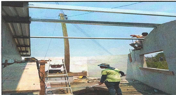
Foto 3: Colocacion de la estructura metalica para el techo de la cocina de la cocina
