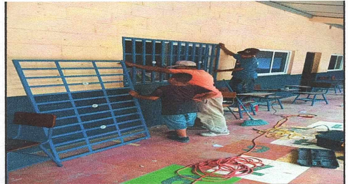
Foto 4: Colocacion de balcones de metal en las aulas que serviran para resguardar los insumos educativos
