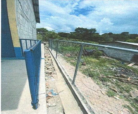
FOTO 1: MURO PERIMETRAL EN MAL ESTADO SE CIRCULARÁ CON VIGA DE CIMENTACION PERALTADA 20 CENTIMETROS ARRIBA DEL NIVEL DEL SUELO NATURAL CON MALLA DE ALAMBRE GALVANIZADO, LA MALLA SE SOSTENDRA EN TUBOS GALVANIZADOS VERTICALES DE 1.50 PULGADAS DE DIAMETRO Y TUBOS PULGADAS DE DIAMETRO Y TUBOS GALVANIZADOS HORIZONTALES DE REMATE DE 1.00 PULGADAS DE DIAMETRO.
