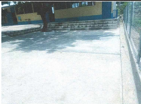
FOTO 5: PATIO DESNIVELADO, SE RELLENARA Y COMPACTARA EL AREA PARA LUEGO FUNDIR UNA TORTA DE CEMENTO DE 7 CM CON MALLA ELECTRO SOLDADA
