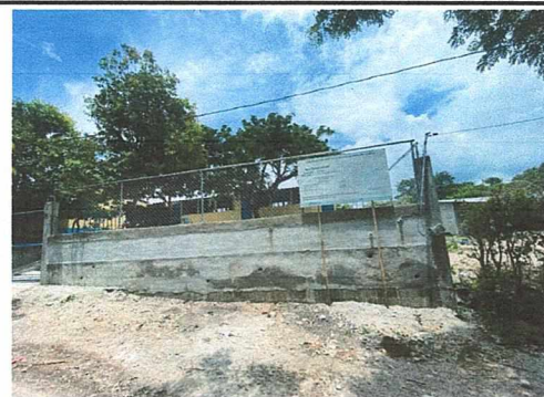
FOTO 6: MURO DE CONTENCIÓN DE MAMPOSTERIA DE PIEDRA A BASE DE CEMENTO CON UNA ALTURA MAXIMA DE 1.50 MTS, LUEGO SE NIVELARA CON MURO DE BLOCK A UNA ALTURA DE UN MT
