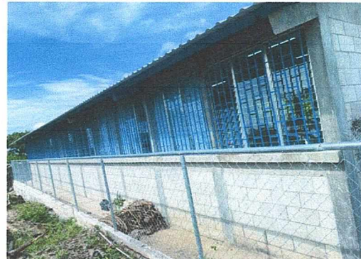
FOTO 2: MURO PERIMETRAL EN MAL ESTADO SE CIRCULARÁ CON VIGA DE CIMENTACION PERALTADA 20 CENTIMETROS ARRIBA DEL NIVEL DEL SUELO NATURAL CON MALLA DE ALAMBRE GALVANIZADO, LA MALLA SE SOSTENDRA EN TUBOS GALVANIZADOS VERTICALES DE 1.50 PULGADAS DE DIAMETRO Y TUBOS PULGADAS DE DIAMETRO Y TUBOS GALVANIZADOS HORIZONTALES DE REMATE DE 1.00 PULGADAS DE DIAMETRO.
