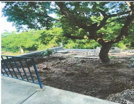
FOTO 5: PATIO DESNIVELADO, SE RELLENARA Y COMPACTARA EL AREA PARA LUEGO FUNDIR UNA TORTA DE CEMENTO DE 7 CM CON MALLA ELECTRO SOLDADA
