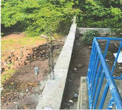
FOTO 1: MURO PERIMETRAL EN MAL ESTADO SE CIRCULARÁ CON VIGA DE CIMENTACION PERALTADA 20 CENTIMETROS ARRIBA DEL NIVEL DEL SUELO NATURAL CON MALLA DE ALAMBRE GALVANIZADO, LA MALLA SE SOSTENDRA EN TUBOS GALVANIZADOS VERTICALES DE 1.50 PULGADAS DE DIAMETRO Y TUBOS PULGADAS DE DIAMETRO Y TUBOS GALVANIZADOS HORIZONTALES DE REMATE DE 1.00 PULGADAS DE DIAMETRO.
