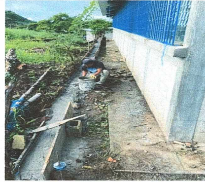
FOTO 2: MURO PERIMETRAL EN MAL ESTADO SE CIRCULARÁ CON VIGA DE CIMENTACION PERALTADA 20 CENTIMETROS ARRIBA DEL NIVEL DEL SUELO NATURAL CON MALLA DE ALAMBRE GALVANIZADO, LA MALLA SE SOSTENDRA EN TUBOS GALVANIZADOS VERTICALES DE 1.50 PULGADAS DE DIAMETRO Y TUBOS PULGADAS DE DIAMETRO Y TUBOS GALVANIZADOS HORIZONTALES DE REMATE DE 1.00 PULGADAS DE DIAMETRO.
