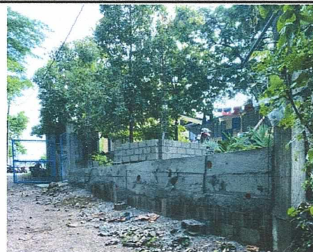
FOTO 6: MURO DE CONTENCIÓN DE MAMPOSTERIA DE PIEDRA A BASE DE CEMENTO CON UNA ALTURA MAXIMA DE 1.50 MTS, LUEGO SE NIVELARA CON MURO DE BLOCK A UNA ALTURA DE UN MT
