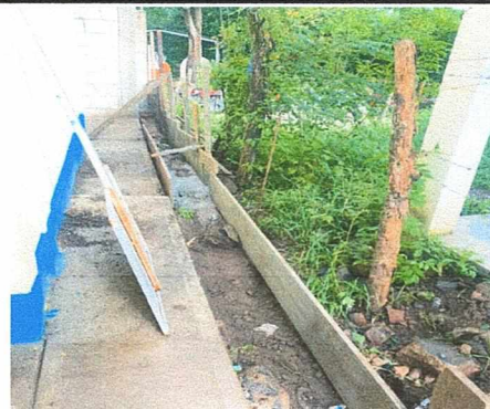
FOTO 4: MURO PERIMETRAL EN MAL ESTADO SE CIRCULARÁ CON VIGA DE CIMENTACION PERALTADA 20 CENTIMETROS ARRIBA DEL NIVEL DEL SUELO NATURAL CON MALLA DE ALAMBRE GALVANIZADO, LA MALLA SE SOSTENDRA EN TUBOS GALVANIZADOS VERTICALES DE 1.50 PULGADAS DE DIAMETRO Y TUBOS PULGADAS DE DIAMETRO Y TUBOS GALVANIZADOS HORIZONTALES DE REMATE DE 1.00 PULGADAS DE DIAMETRO.
