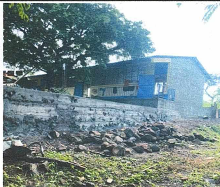
FOTO 3: MURO PERIMETRAL EN MAL ESTADO SE CIRCULARÁ CON VIGA DE CIMENTACION PERALTADA 20 CENTIMETROS ARRIBA DEL NIVEL DEL SUELO NATURAL CON MALLA DE ALAMBRE GALVANIZADO, LA MALLA SE SOSTENDRA EN TUBOS GALVANIZADOS VERTICALES DE 1.50 PULGADAS DE DIAMETRO Y TUBOS PULGADAS DE DIAMETRO Y TUBOS GALVANIZADOS HORIZONTALES DE REMATE DE 1.00 PULGADAS DE DIAMETRO.
