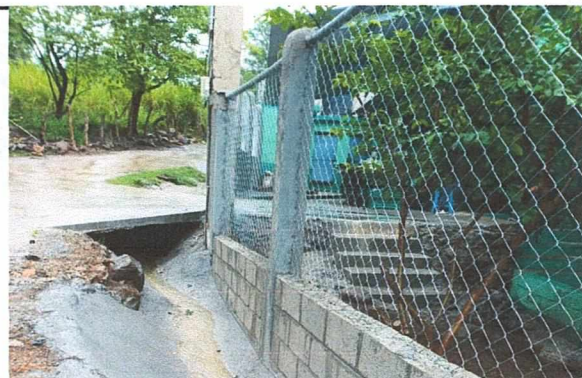
Foto 4: Reparación de cuneta y muro rompe corriente terminada en su totalidad
