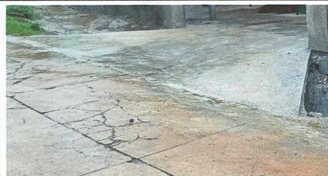
Foto 5: Reparación de banquete terminada
