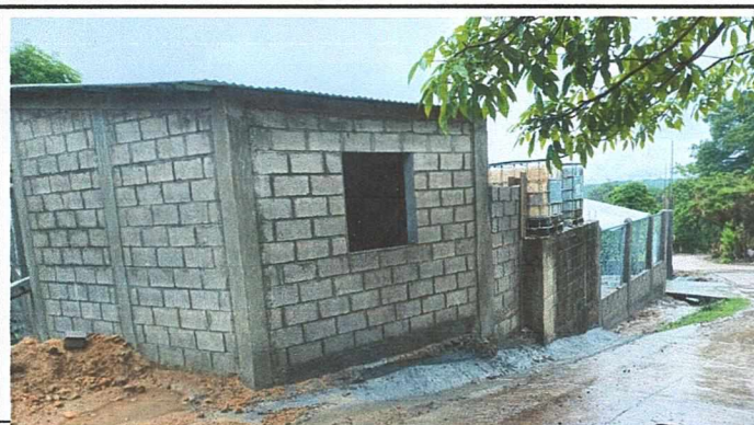
Foto 1: Reparación de cocina, cuneta, muro perimetral y colocación de portón terminada
