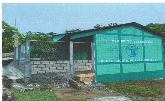
Foto 3: Reparación de cerco perimetral terminada
