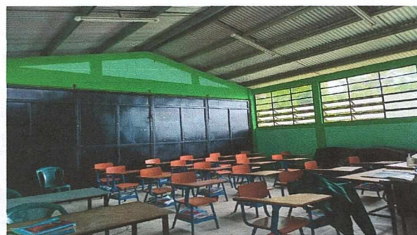
Foto 6: Aplicación de pintura en paredes interiores y exteriores terminada
