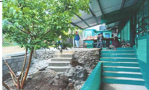
Foto 2: Circulación, pintura interior y exterior terminada
