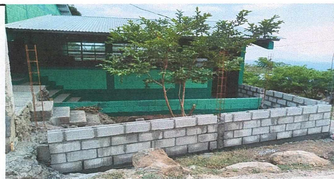
Foto 5: Reconstrucción de Borda rompe corriente con block y cemento
