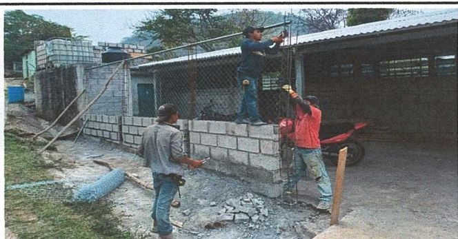
Foto 3: Reparación de cerco perimetral
