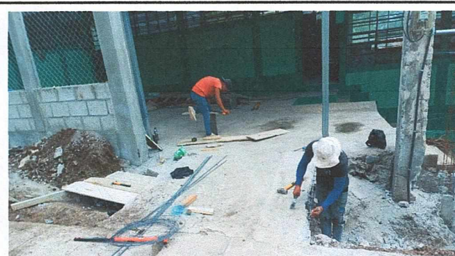
Foto 4: Reparación de Banqueta exterior
