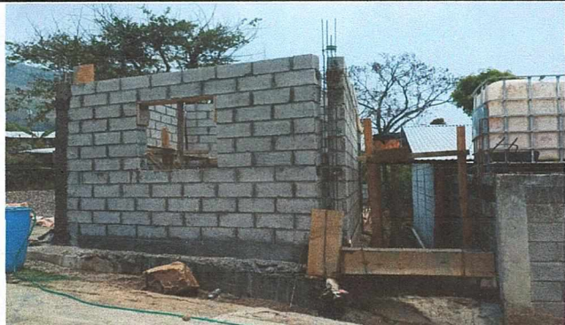
Foto1: Reconstrucción de Cocina
