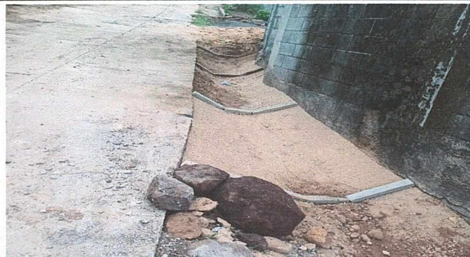
Foto 2: Reparación de Cuneta
