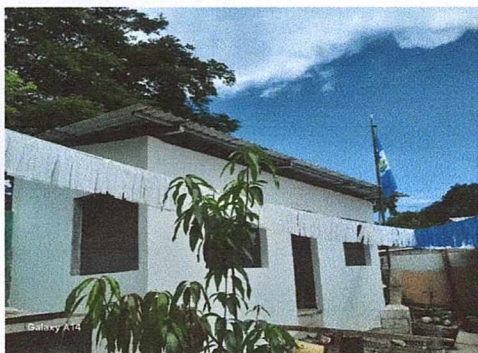
Foto 3: construccion de cocina
