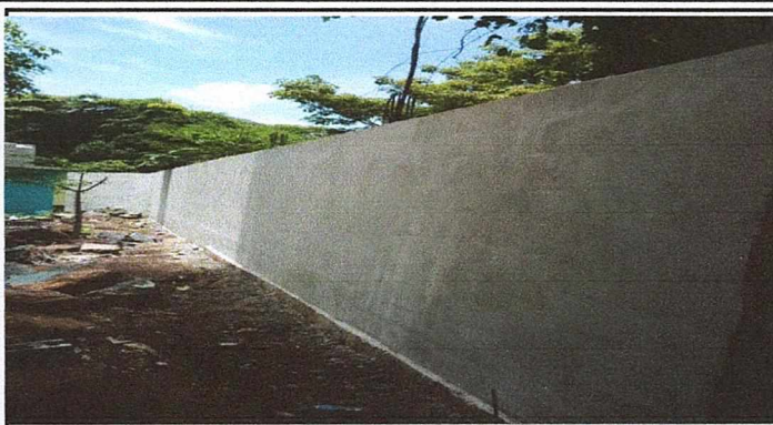
Foto 2: construccion de muro perimetral
