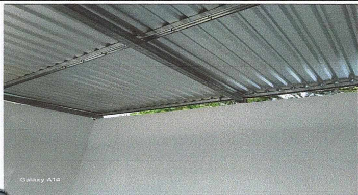
Foto1: Colocación de techo a cocina
