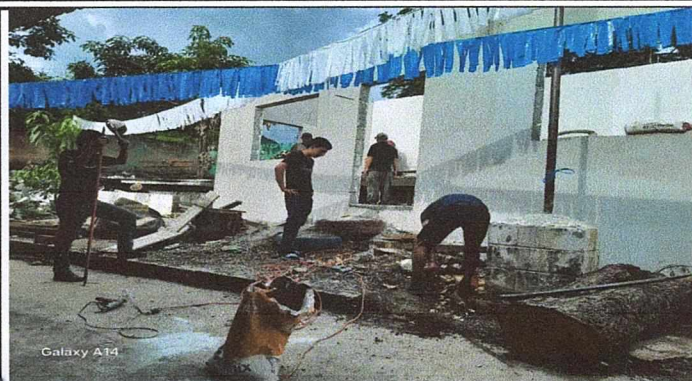
Foto1: Construcción de cocina
