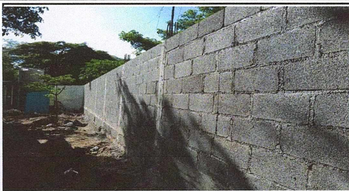
Foto 2: construccion de muro perimetral
