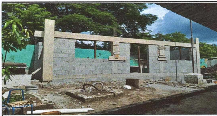
Foto 4: Construcción de cocina
