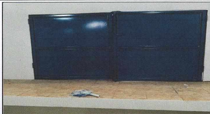
Foto 2: Remodelacion de bodega
