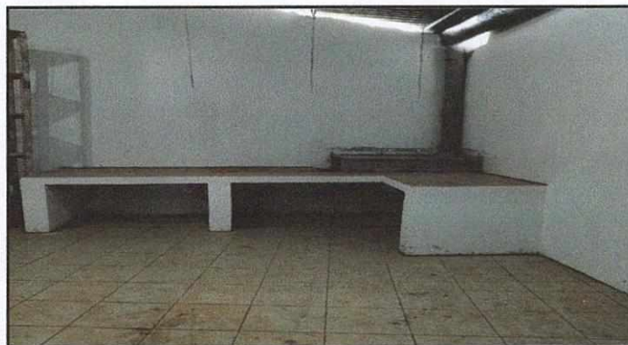
Foto 4: Remodelacion de cocina
