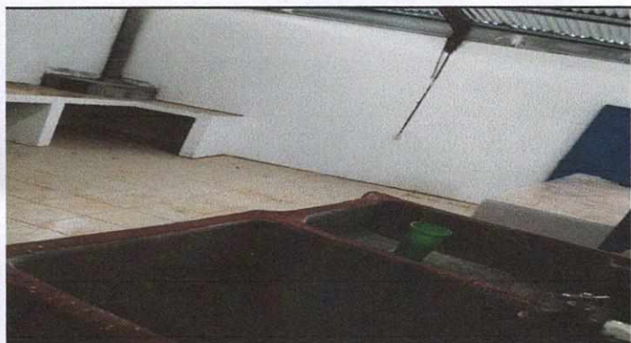
Foto 3: Remodelacion de cocina
