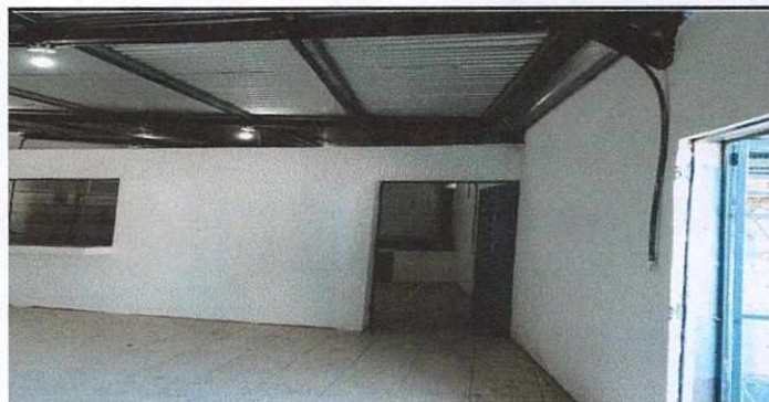
Foto 6: Remodelacion de bodega y direccion
