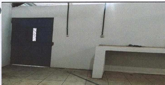
Foto 5: Remodelacion de cocina
