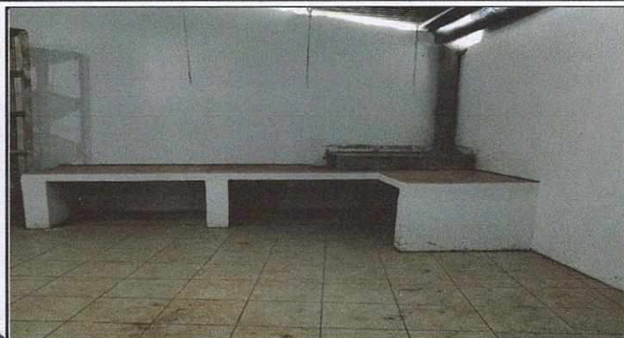
Foto 1: Remodelacion de cocina
