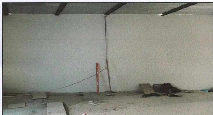
Foto 3: Remodelacion de Dirección
