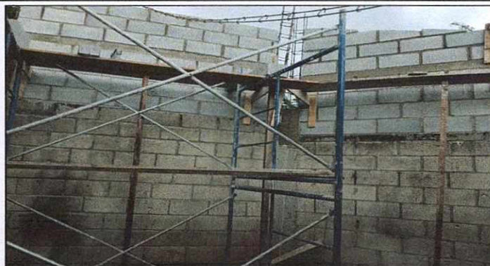
Foto 2: Remodelacion de bodega
