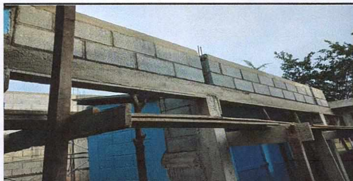
Foto 6: Remodelacion de bodega
