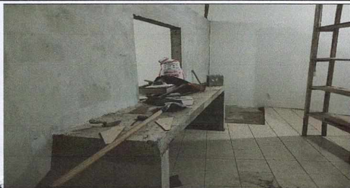
Foto1: Remodelacion de cocina
