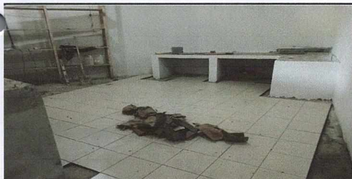
Foto 5: Remodelacion de cocina
