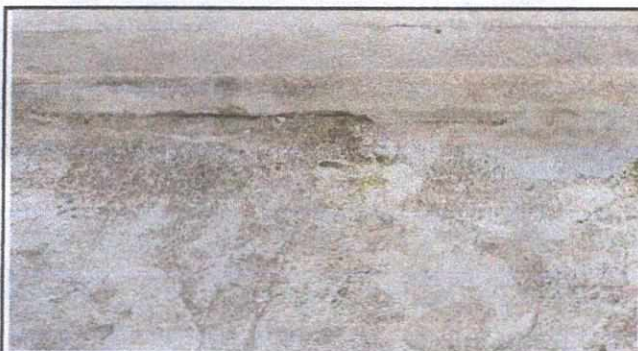
Foto 3: Reparación de suelo en bodega.
