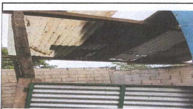
Foto 4: Remozamiento de techo para bodega
