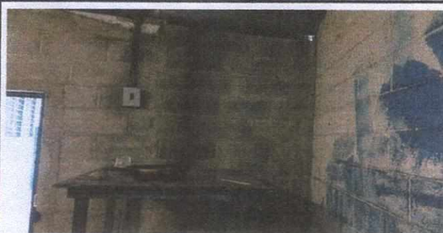
Foto 5: repello de paredes en cocina.
