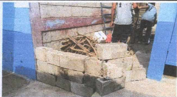
Foto 1: Reparación y nivelación de paredes en bodega.
