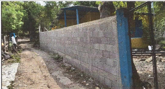
Foto1: CONSTRUCCIÓN DE MURO PERIMETRAL
