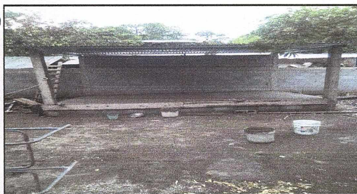
Foto 5: CONSTRUCCION DE GALERA PARA ESCENARIO
