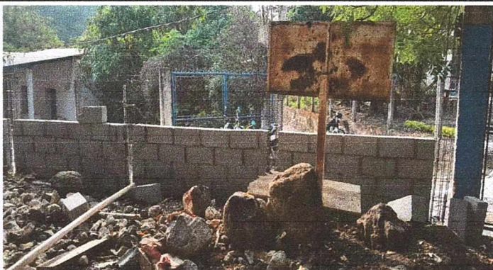
Foto 2: CONSTRUCCION DE MURO PERIMETRAL
