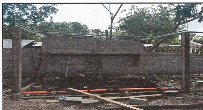
Foto 5: CONSTRUCCION DE GALERA PARA ESCENARIO
