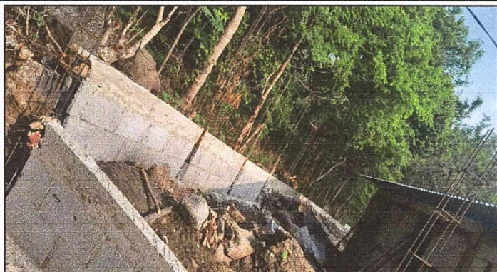
Foto1: CONSTRUCCIÓN DE MURO PERIMETRAL
