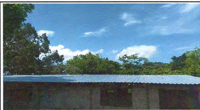
Foto 2: Sustrucción de lamina por lamina troquelada aluzinc
