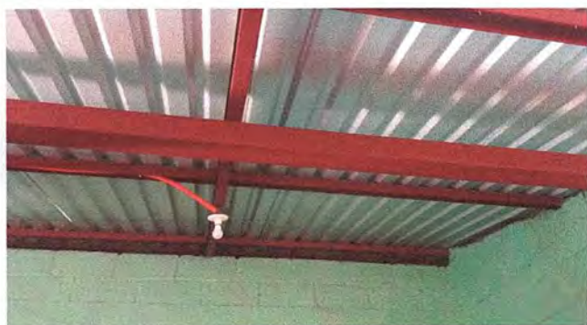
Foto 3: Mantenimiento a estructura de soporte de metal
