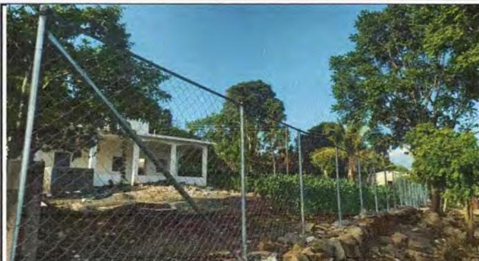
Foto1: Reparación de muro de contención.
