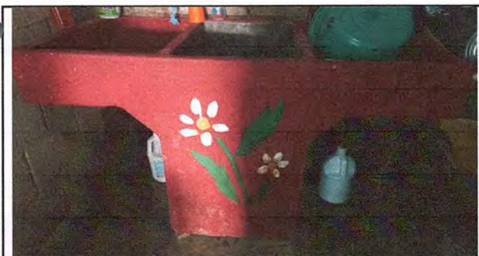
Foto 5: Sustrucción de pila de cemento de dos lavadores.
