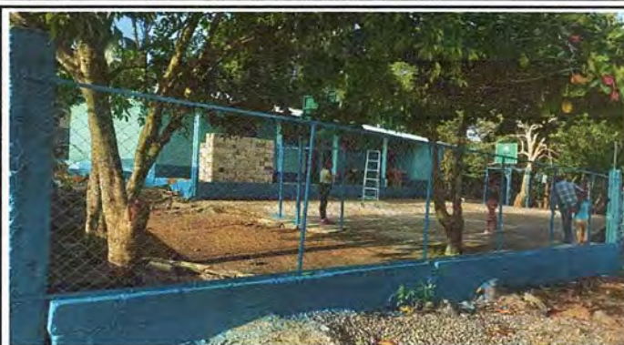
Foto 2: Reparación de muro de contención.
