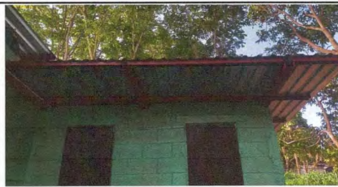
Foto 4: Sustrucción de estructura de soporte de madera por estructura de metal y lamina
