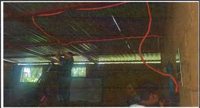
Foto 2: Reparación de sistema electrico
