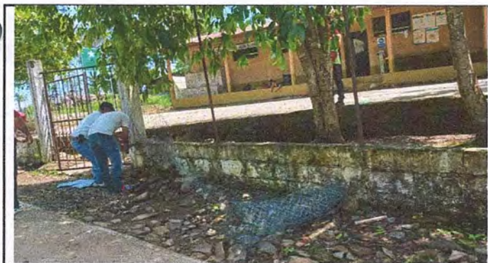
Foto 5: reparacion muro perimetral
