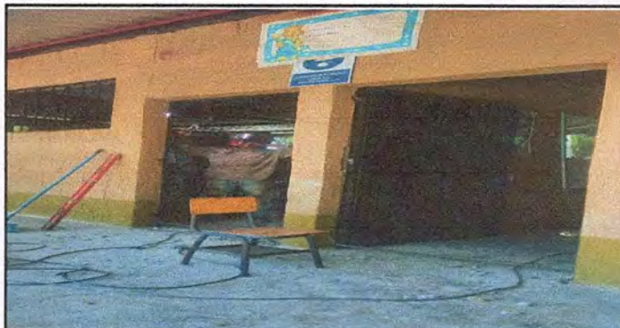
Foto 4: Sustitución de puertas de aula
