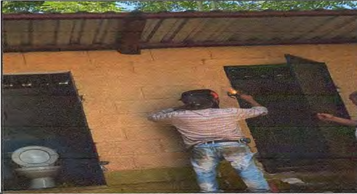
Foto1: Sustitución de puerta de baños
