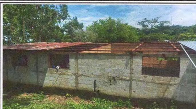
Foto 2: Sustitucion de lamina por lamina troquelada aluzinc
