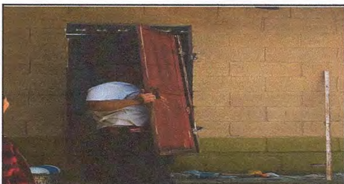
Foto 6: Sustitución de puerta de baños
