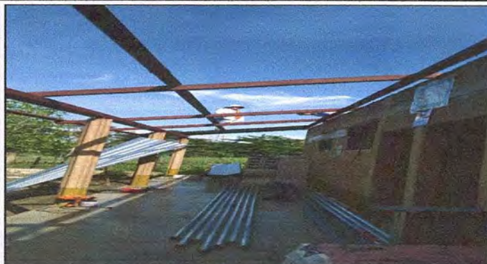
Foto1: Sustitucion de lamina por lamina troquelada aluzinc
