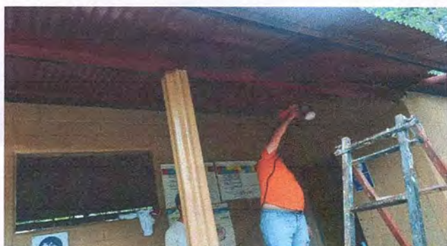
Foto 3: Mantenimiento a estructura de soporte de metal
