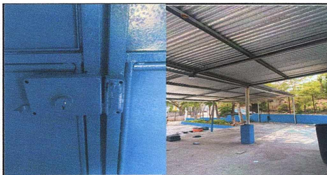
Foto 6: Cambio de Chapa y colocación de techo.
