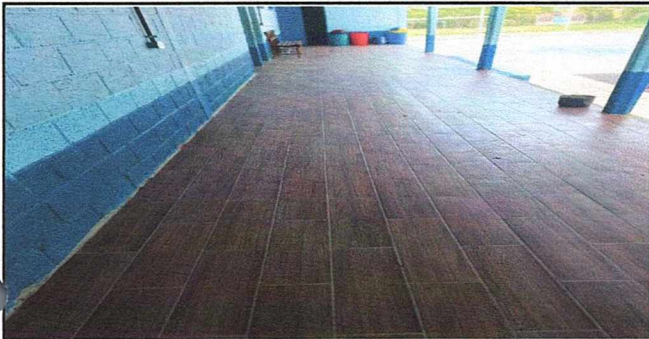
Foto1: Finalización de instalación de piso.
