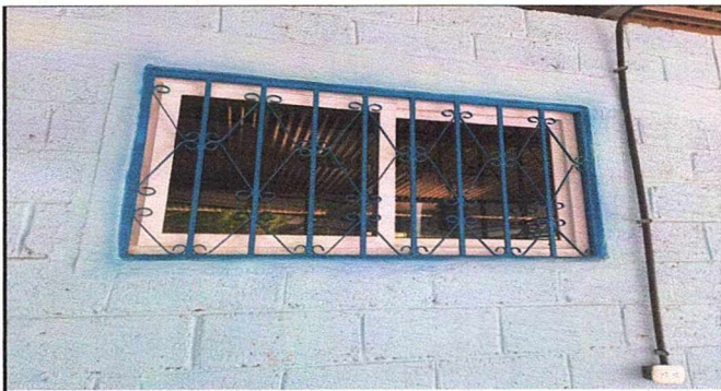
Foto 3: Instalación de ventanas de PVC y balcones pintados.
