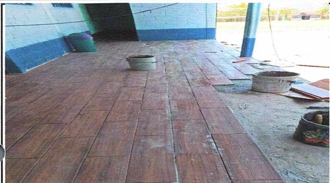
Foto1: Corredor en proceso de instalación de piso.
