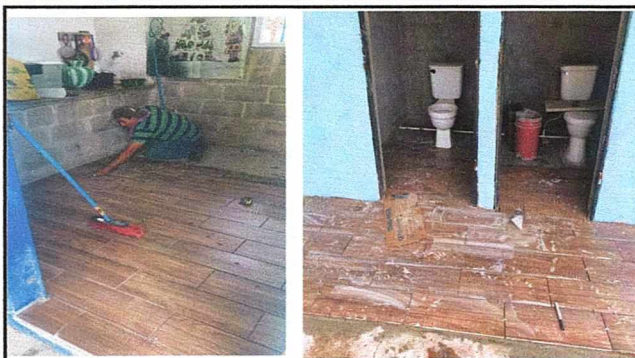
Foto 2: Cosina y sanitarios en proceso de instalación de piso.
