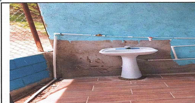
Foto 5: Instalacion de lavamanos.
