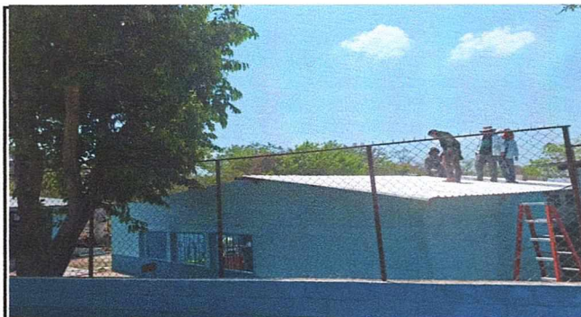
Foto 4: Colocación de techo.
