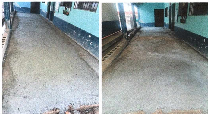
Foto1: Cambio de piso de torta de cemento
