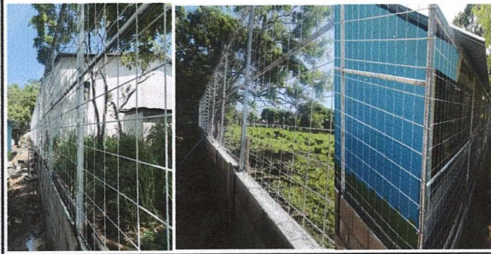
Foto 6: Muro perimetral alrededor de la escuela
