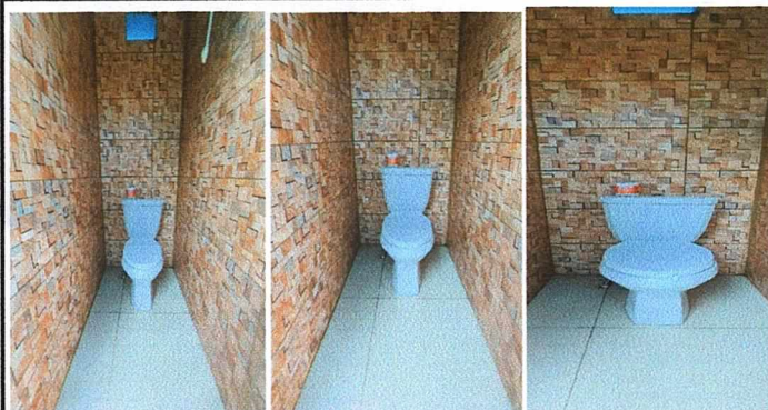
Foto 3: Cambio de inodoros e instalación de cerámico y azulejo
