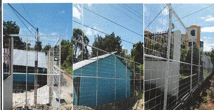
Foto 5: Parte de enfrente del muro perimetral de la escuela
