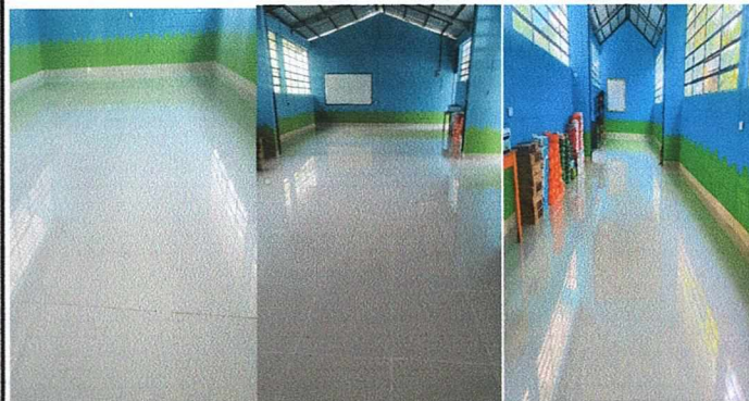
Foto 4: Instalación de piso cerámico
