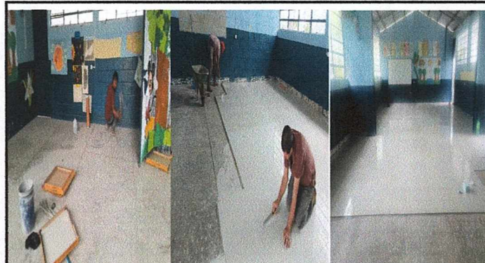
Foto 4: Instalación de piso cerámico
