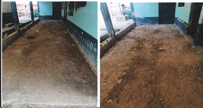
Foto1: Cambio de piso de torta de cemento
