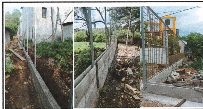
Foto 6: Muro perimetral alrededor de la escuela
