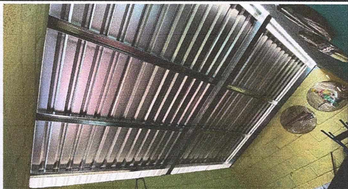
Foto 2: Sustitución de duralita por lamina aluzinc calibre 24
