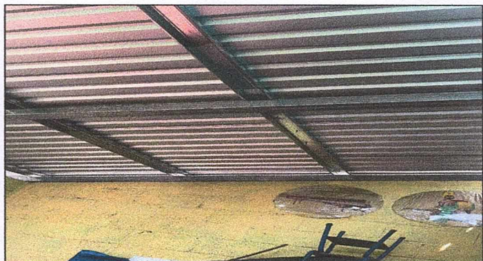
Foto 4: Sustitución de duralita por lamina aluzinc calibre 24
