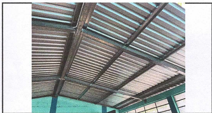
Foto 6: Sustitución de duralita por lamina aluzinc calibre 24
