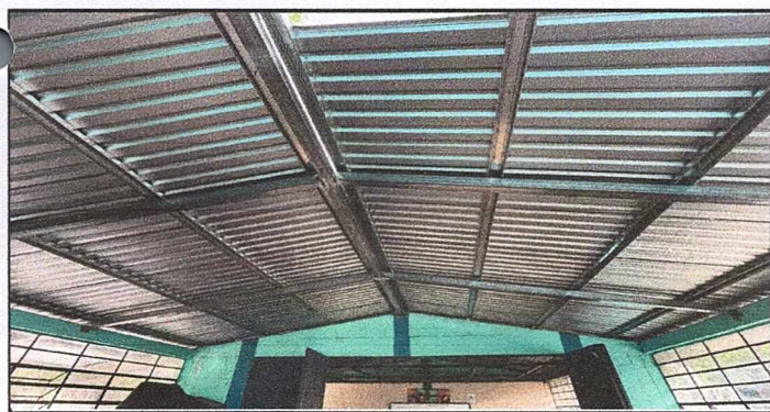
Foto 5: Sustitución de duralita por lamina aluzinc calibre 24
