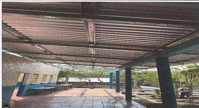
Foto 1: Sustitución de duralita por lamina aluzinc calibre 24
