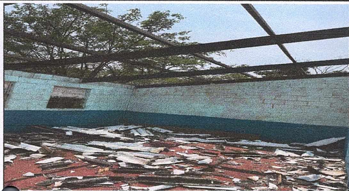
Foto 1: Sustitución de costanera de madera por costanera de metal.
