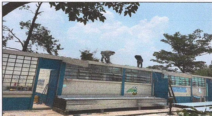
Foto 3: Sustitución de costanera de madera por costanera de metal.
