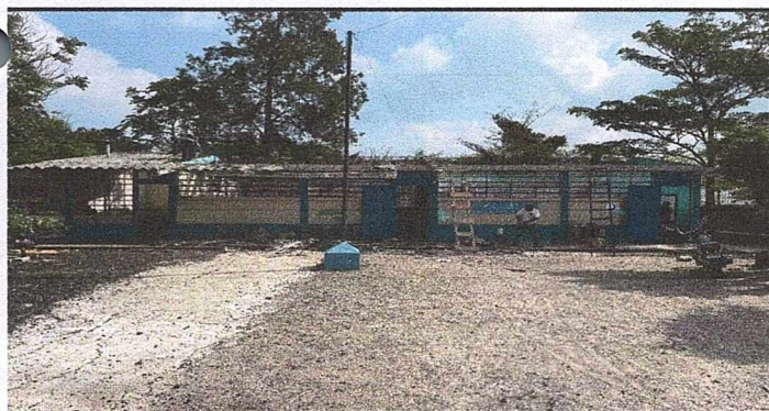
Foto 5: Sustitución de duralita por lamina aluzinc calibre 24
