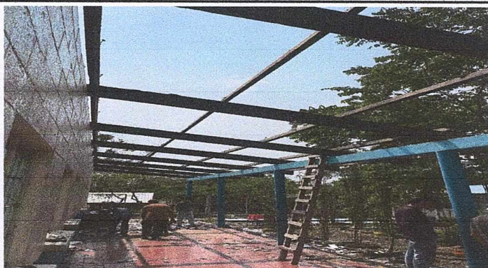
Foto 2: Sustitución de costanera de madera por costanera de metal.
