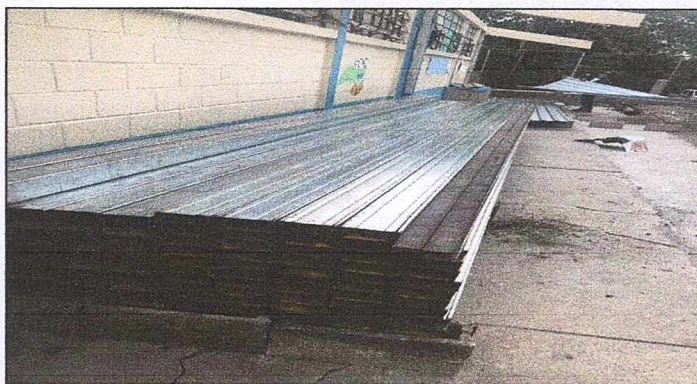
Foto 4: Sustitución de costanera de madera por costanera de metal.
