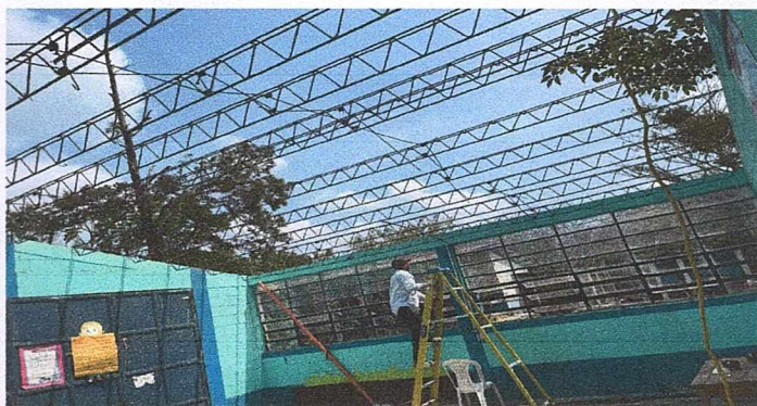
Foto 6: Sustitución de duralita por lamina aluzinc calibre 24
