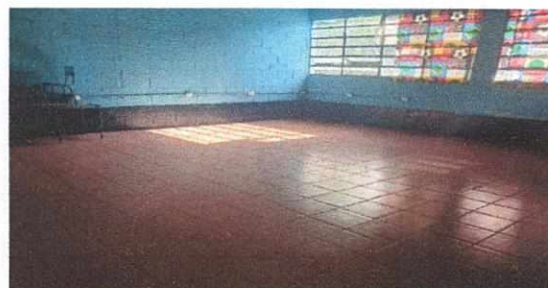
Foto 4: Modulo de Aula No. 2 Instalación de Piso Ceramico + Sustrucción de Chapa de Metal para puerta.
