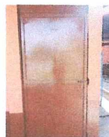
Foto 12: Reparación de puertas, cambio de a chapas.
