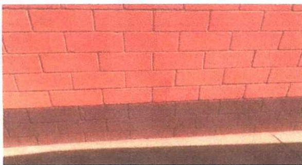
Foto 9: Pintura general de Escuela + pintura de muros exteriores e interiores.
