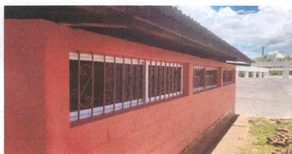
Foto 3: Modulo de Aula No. 2 Sustrucción de Ventana de Metal por ventana de vidrio para mayor Higiene.
