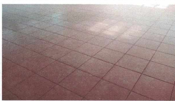
Foto 2: Modulo de Aula 1 Sustrucción de piso ceramico, reparación y sustrucción de chapa de metal para puerta.
