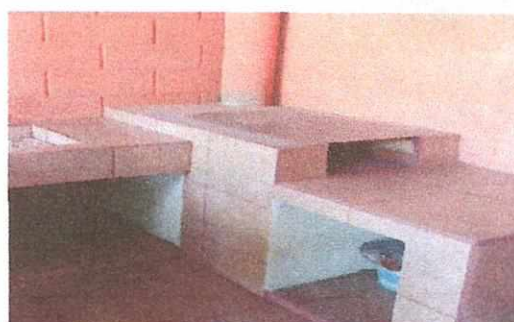
Foto 10: Cocina, instalación de chapa de metal, mejoramiento de polleton e instalación de piso cerámico.
