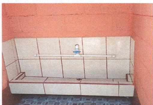
Foto 5: Migitorio Sustrucción de estructura de soporte de madera, por metal, con lamina, teparación de pared de baño, reparación de migitorio de memento a ceramico, instalación de piso ceramico, Sustrucción de
