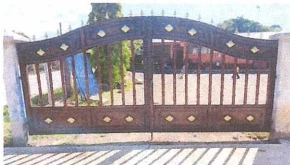
Foto 7: Portón Principal Sustitución de portón de metal.
