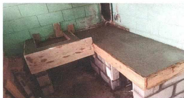
Foto 10: Cocina, instalación de chapa de metal, mejoramiento de polleton e instalación de piso cerámico.
