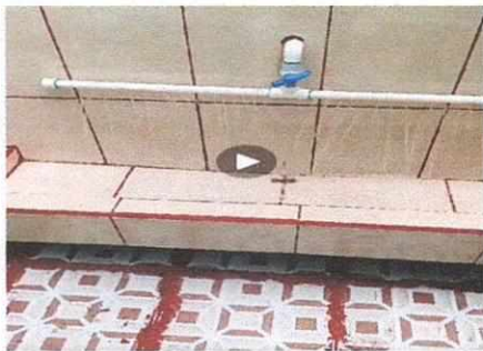
Foto 5: Migitorio Sustitucion de estructura de soporte de madera por metal, con lamina, tearación de pared de baño, reparación de memento a ceramico, instalación de piso ceramico, sustitución de
