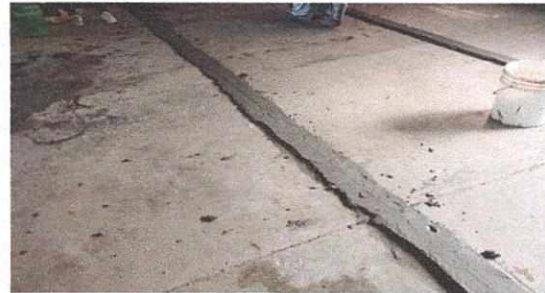
Foto 2: Modulo de Aula 1 Sustitución de piso ceramico, reparación y sustitución de chapa de metal para puerta.
