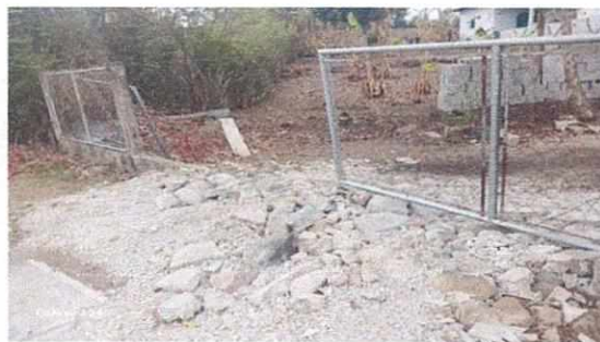
Foto 8: Portón Secundario instalación de Portón de metal, reforzamiento de columnas perimetrales para la colocación de portón metálico.
