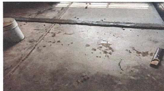
Foto 4: Modulo de Aula No. 2 Instalación de Piso Ceramico + Sustitución de Chapa de Metal para puerta.
