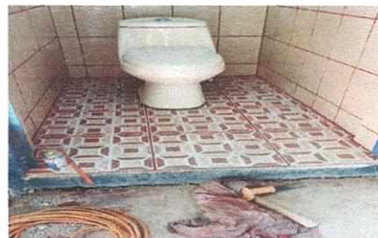
Foto 6: Instalación de piso ceramico, Sustitución de Inodoros.
