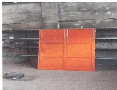
Foto 12: Reparación de puertas , cambio de a chapas.
