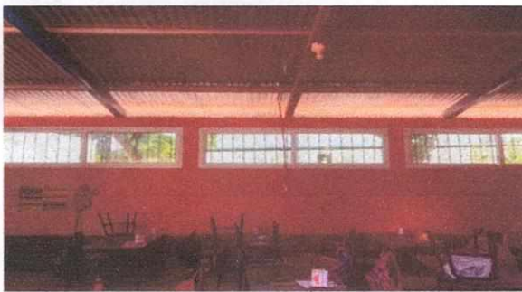
Foto 3: Modulo de Aula No. 2 Sustitución de Ventana de Metal por ventana de vidrio para mayor Higiene.
