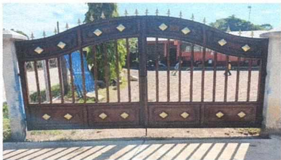
Foto 7: Portón Principal Sustitución de portón de metal.
