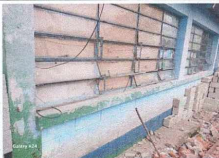
Foto 11: Balcones Metalicos, Instalación de balcones.
