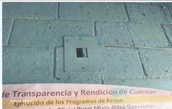
Foto1: Sustrucción de ducto electrico + Sustrucción de Filipones.
