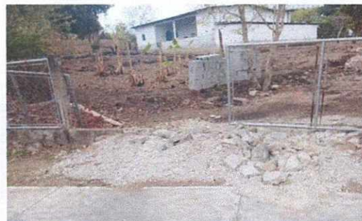
Foto 8: Portón Secundario instalación de Portón de metal, reforzamiento de columnas perimetrales para la colocación de portón metálico.
