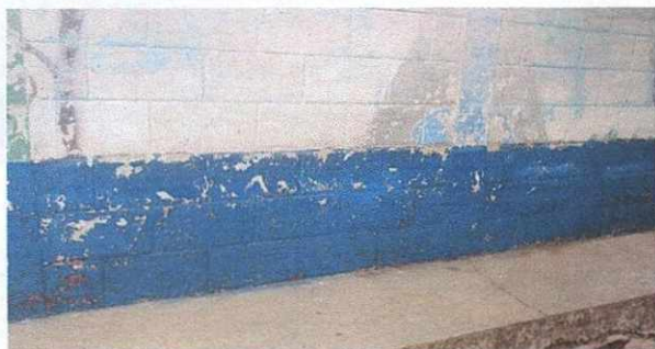
Foto 9: Pintura general de Escuela + pintura de muros exteriores e interiores.
