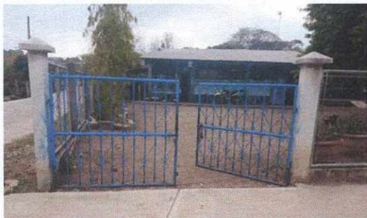
Foto 7: Portón Principal Sustitución de portón de metal.
