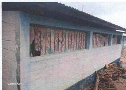
Foto 3: Modulo de Aula No. 2 Sustrucción de Ventana de Metal por ventana de vidrio para mayor Higiene.
