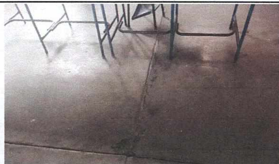
Foto 4: Modulo de Aula No. 2 Instalación de Piso Ceramico + Sustrucción de Chapa de Metal para puerta.
