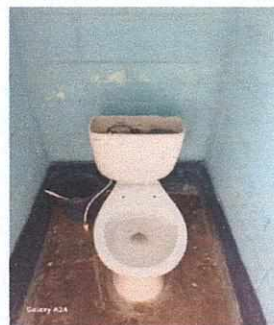
Foto 6: Instalación de piso ceramico, Sustrucción de Inodoros.
