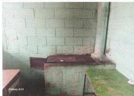
Foto 10: Cocina, Instalación de chapa de metal, mejoramiento de polleto e instalación de piso cerámico.
