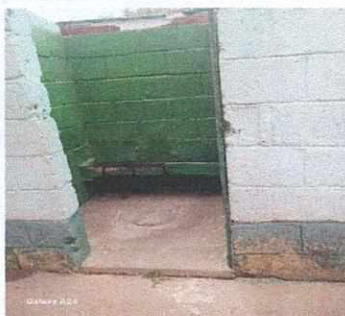
Foto 5: Migitorio Sustrucción de estructura de soporte de madera, por metal, con lamina, teparación de pared de baño, reparación de migitorio de memento a ceramico, instalación de piso ceramico, sustrucción de.
