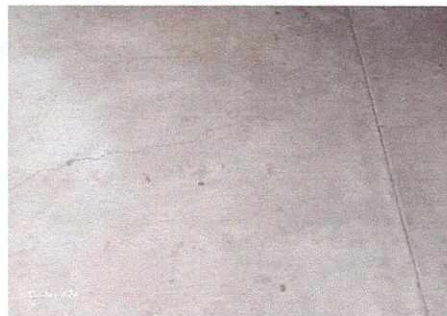
Foto 2: Modulo de Aula 1 Sustrucción de piso ceramico, reparación y sustrucción de chapa de metal para puerta.
