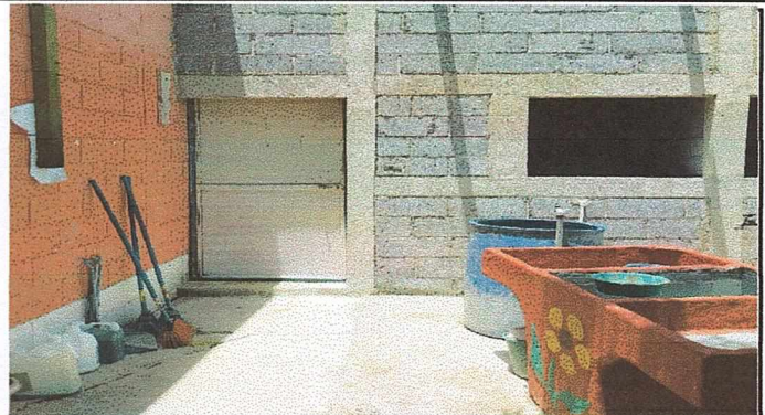
Foto 2: Construcción de cocina y bodega.
