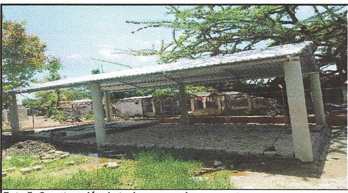
Foto 5: Construcción de techo escenario.
