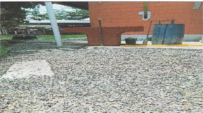
Foto 3: Construcción de cocina
