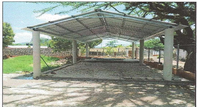
Foto 4: Construcción de techo escenario.
