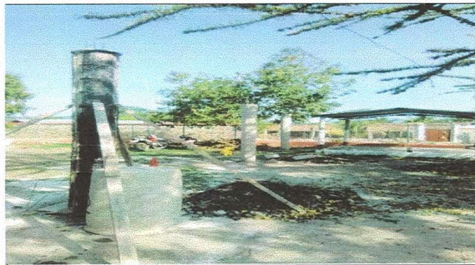
Foto 4: Construcción de techo escenario.
