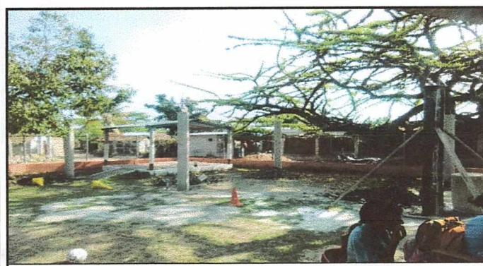
Foto 5: Construcción de techo escenario.
