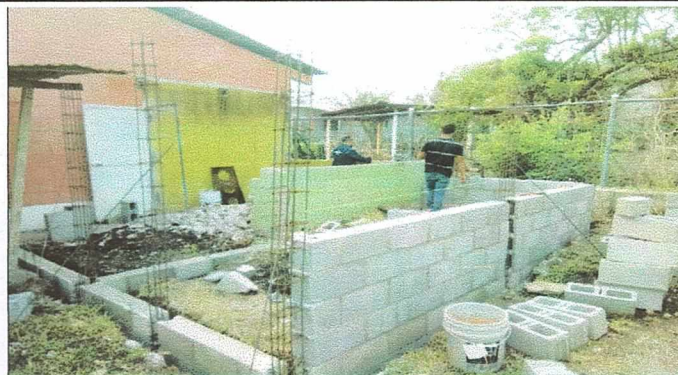
Foto 2: Construcción de cocina y bodega.
