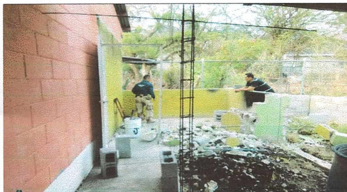
Foto 3: Construcción de cocina
