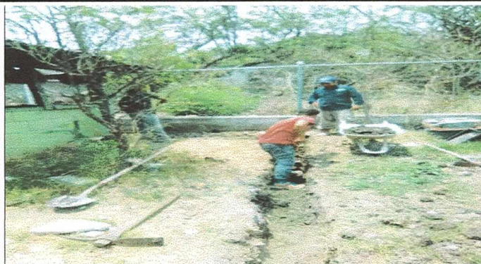
Foto 1: Construcción de bodega.
