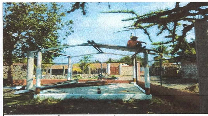
Foto 6: Construcción de techo escenario.
