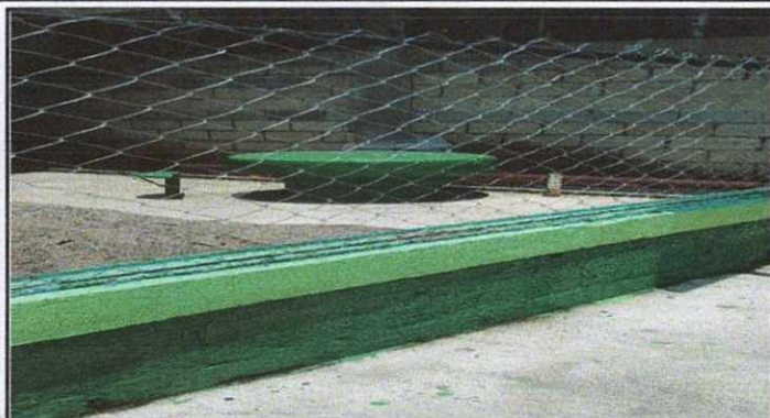
Foto 1: Sustrucion de malla perimetral
