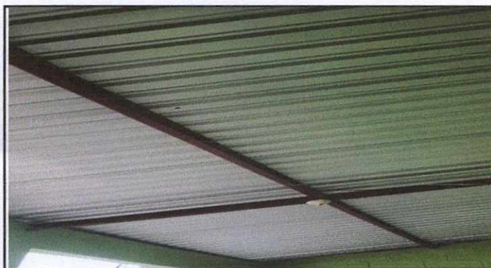
Foto 3: Sustrucion de lamina de aluzinc
