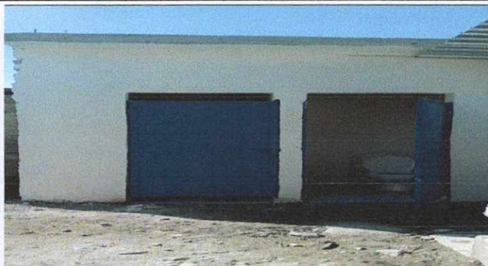
Foto 2: Construcccion de baños
