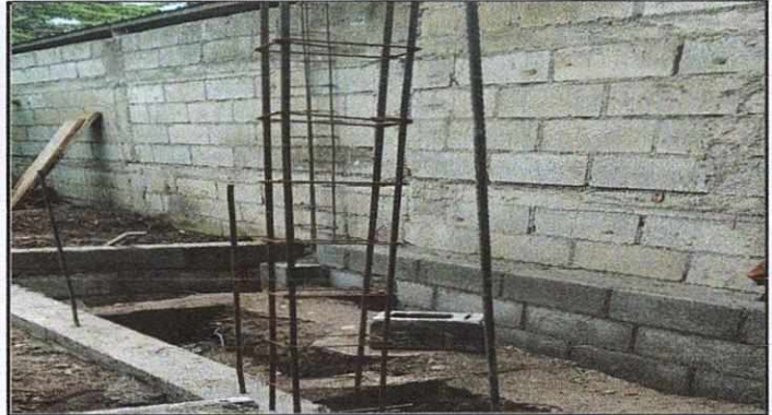
Foto 2: Construcccion de baños
