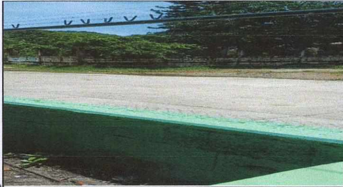
Foto 1: Sustrucion de malla perimetral
