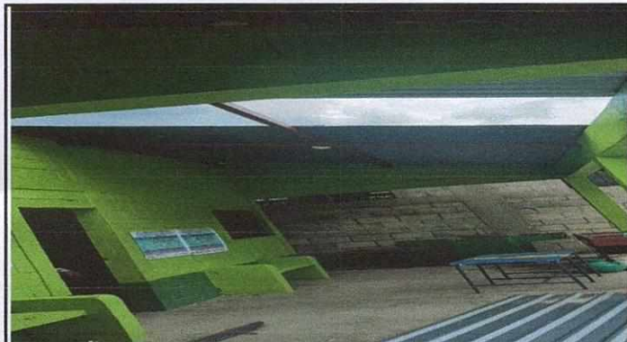
Foto 3: Sustrucion de lamina de aluzinc
