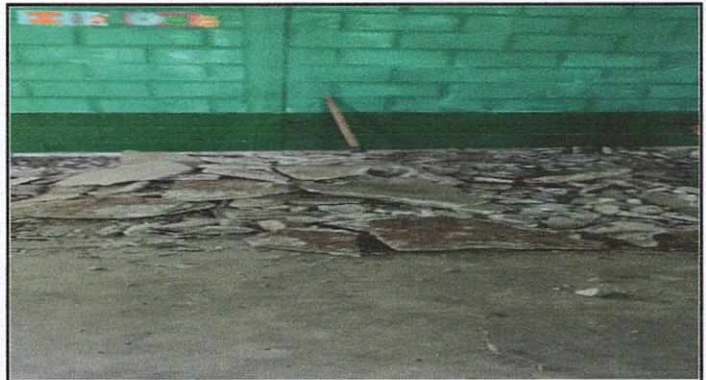
Foto 4: Colocación de piso ceramico
