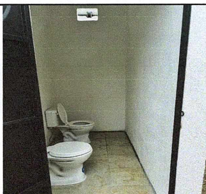
Foto 3: Baño remodelado, con cambio de sanitarios, pared de block y techo de terraza.
