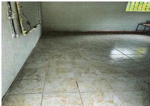
Foto1: Colocación de piso Cerámico en aula.
