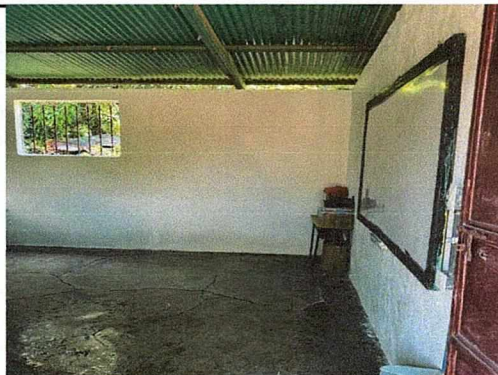
Foto 2: Aula con repello en paredes y reforzamiento de grietas.
