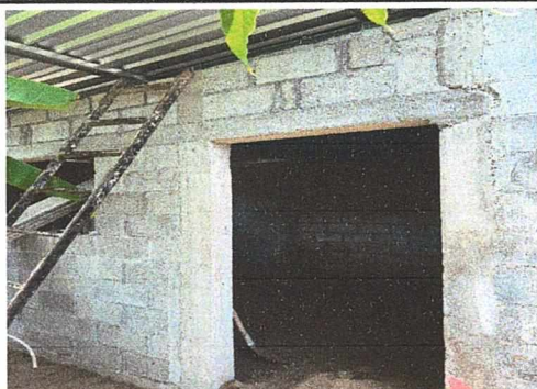
Foto 5: Remodelación del aula, repello, sustitución de pared de block, piso cerámico, reparación de techo de lamina, puerta nueva y ventana, para mejor ventilación
