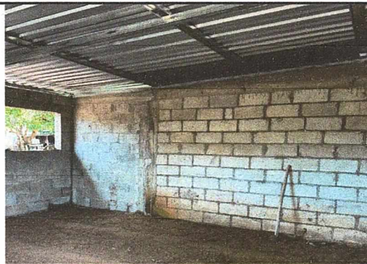
Foto 2: Remodelando la torta, se cambiara por piso cerámico.
