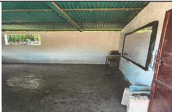
Foto1: Remodelando de torta de cemento, se cambiara por piso cerámico
