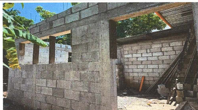
Foto 6: Remodelación del aula, repello, sustitución de pared de block, piso cerámico, reparación de techo de lamina, puerta nueva y ventana, para mejor ventilación
