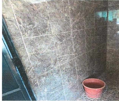
Foto 2: PAREDES DEL BAÑO REMODELADAS
