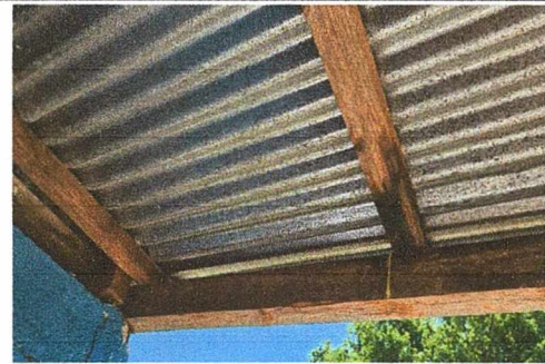
Foto 4: REPARACIÓN DEL TECHO
