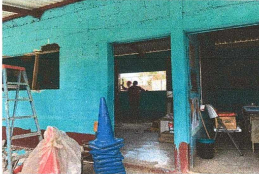
Foto 1: CAMBIO DE VENTANAS
