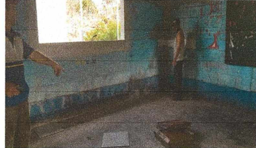
Foto 2: AULA, CAMBIO DE PISO
