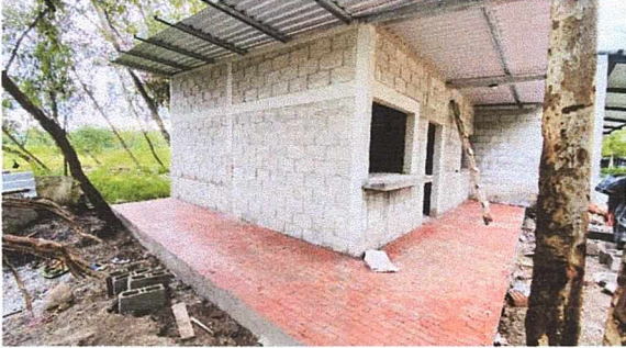
Foto 1: Fundición de banqueta de concreto
