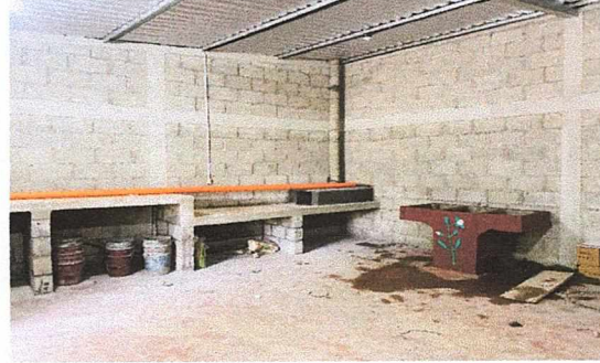
Foto 2: Instalación de Pila, Incluye drenajes hidrosanitarios
