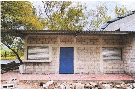
Foto 3: Instalación de puerta de metal con chapa marca Yale y Instalación de ventanas tipo persianas enrollables.
