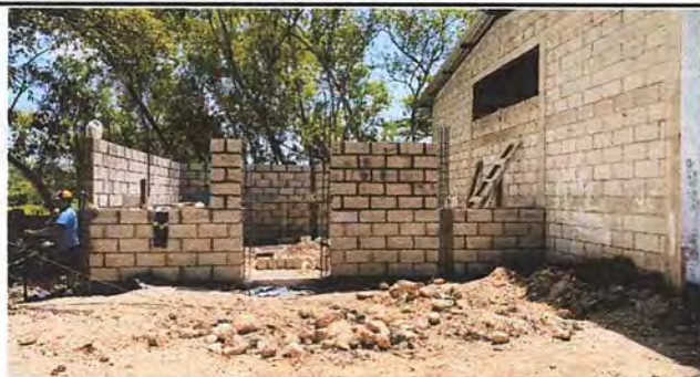
Foto 3: Levantado de muros, con textura de block visto sisado y tallado de columnas
