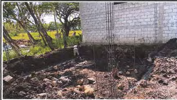
Foto 2: Cimiento corrido tipo mamposteria de Piedra
