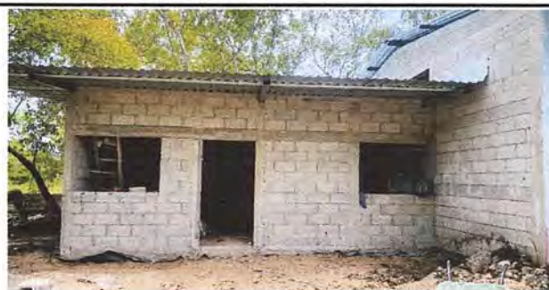
Foto 4: Intalacion de techo con estructura de soporte de metal
