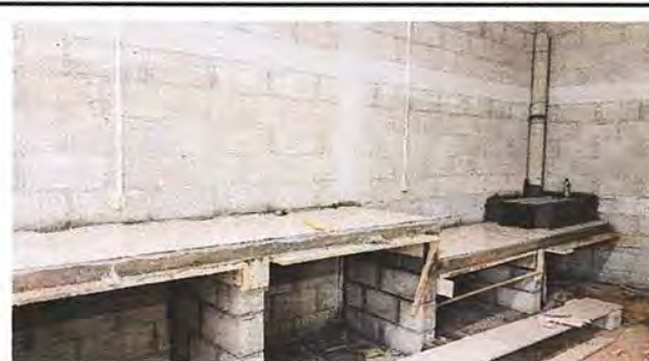
Foto 6: Reparacion de pollo fuego
