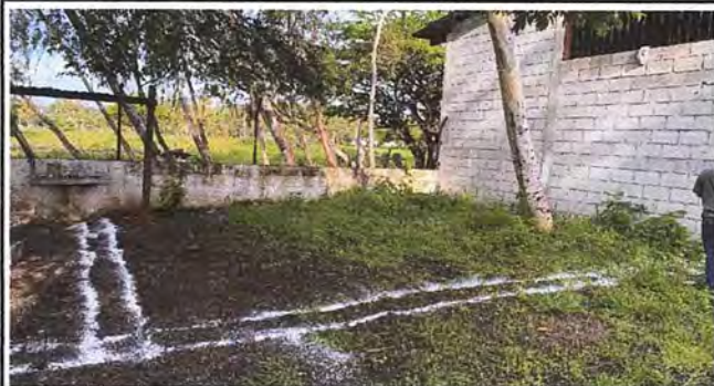
Foto1: Trazado de medidas para realizar el mejoramiento en area de cocina.
