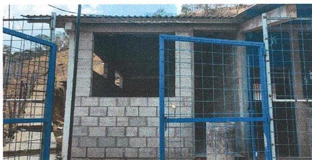
Aula en proceso de terminar
