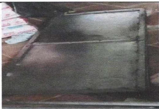
Foto 3: FABRICACION DE PUERTAS PARA SANITARIOS
