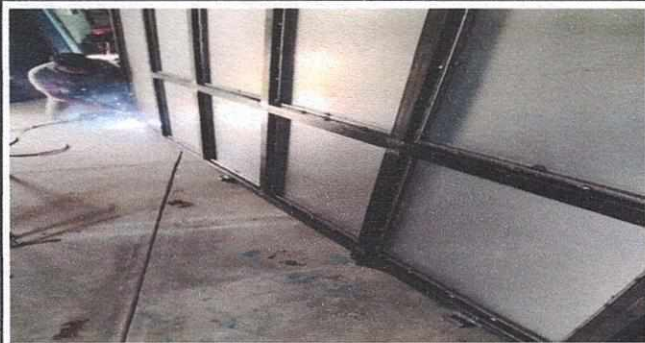
Foto1: FABRICACION DE PORTON QUE SERVIRA PARA DIVISION DE AULAS
