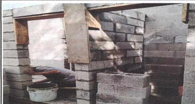
Foto 2: LEVANTADO DE PARTES PARA SANITARIOS
