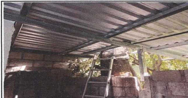
Foto 6: COLOCACION DE ESTRUCTURA Y LAMINA PARA GALERA QUE SERVIRA DE BODEGA
