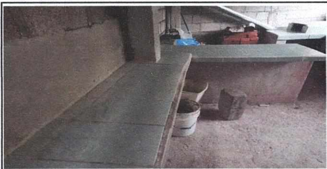
Foto 5: LEVANTADO DE MESETAS Y COLOCACION DE AZULEJOS PARA LA COCINA
