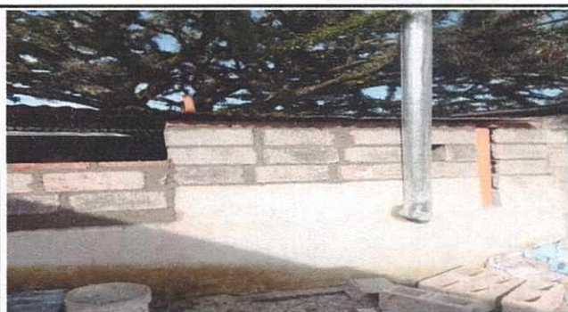
Foto 4: LEVANTADO DE PARED Y COLOCACION DE TUBO DE CHIMENEA EN COCINA
