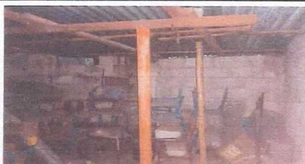
Foto 2: cambio de techo area de bodega, se encuentra construido con madera y lamina en mal estado, se procedera a instalar estructura metalica y lamina troquelada
