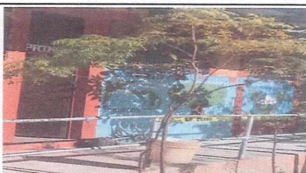
Foto 4: mantenimiento baranda, no presenta seguridad, se colocara un metro mas alta con malla galvanizada
