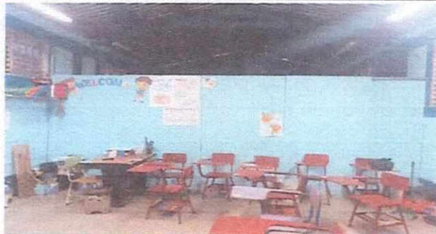
Foto 1: separacion de aulas, estan separadas por tabla yeso y se colocara porton corredizo, para mejor resguardo de materiales y seguridad de los estudiantes
