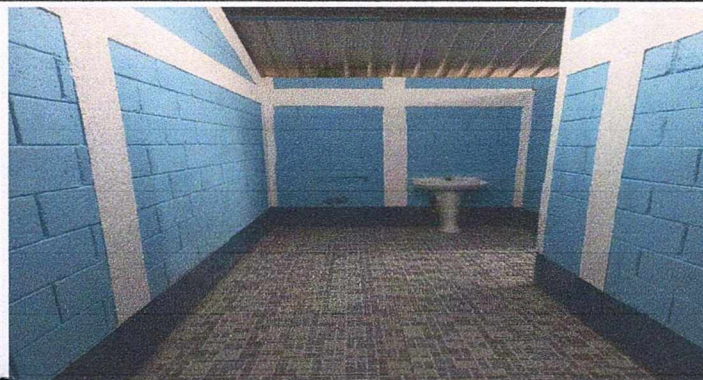
Foto1: aplicación de pintura, sustitución de lavamanos y piso.
