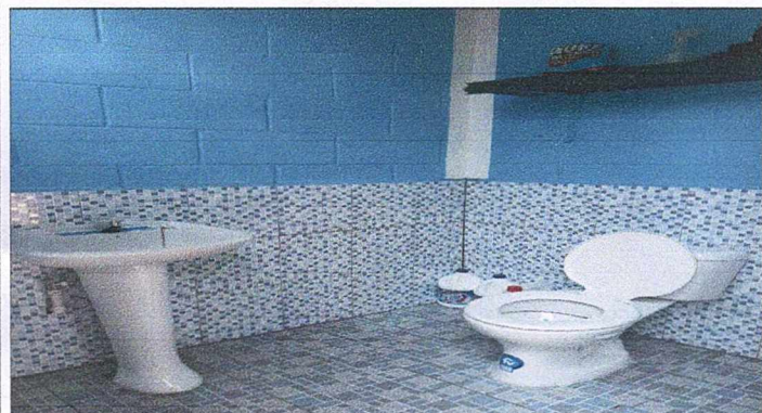
Foto 3: Pintura, piso sustitución de lavamanos, inodoro, sustitución azulejo.
