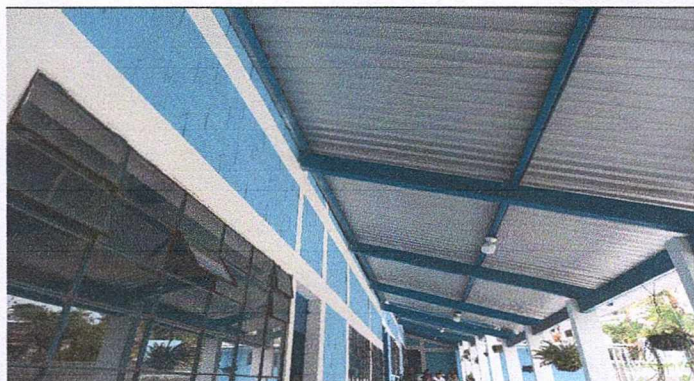
Foto 4: reparación sistema electrico.
