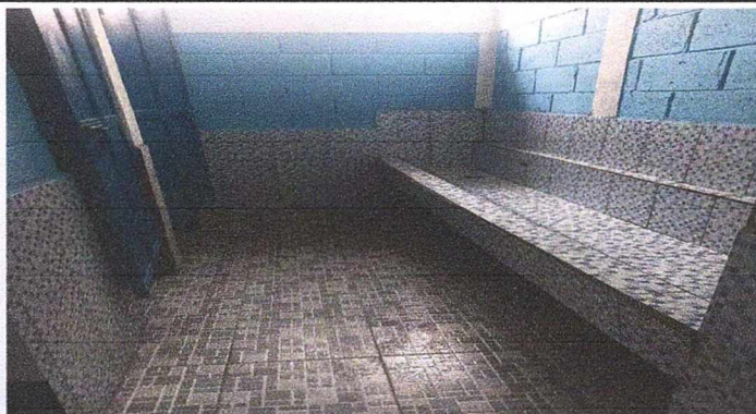
Foto 2: piso, sustitución mingitorio.
