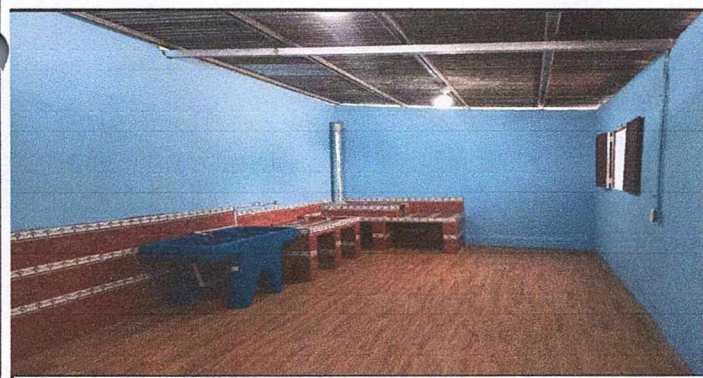
Foto 5: pintura, sustitución piso ceramico en paredes, chimenea, azulejo y pila
