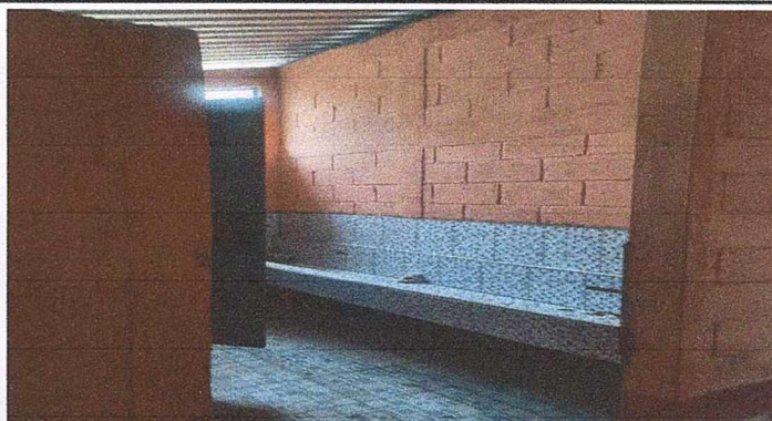
Foto 2: Sustrucción de mingitorio
