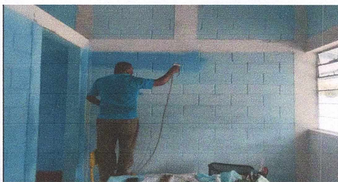
Foto 6: Pintura en muros y exteriores
