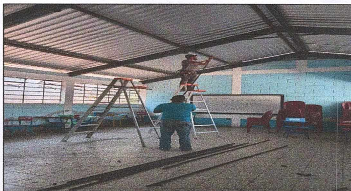
Foto 4: Reparación sistema electrico
