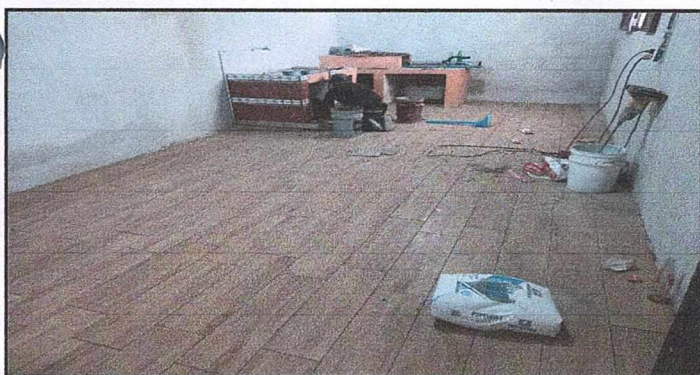
Foto 5: Sustrucción de azulejo y piso
