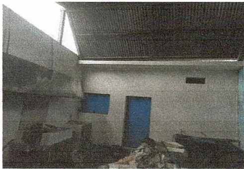
Foto 3: Se unieron los dos espacios y se colocó una puerta y una ventana de metal.
