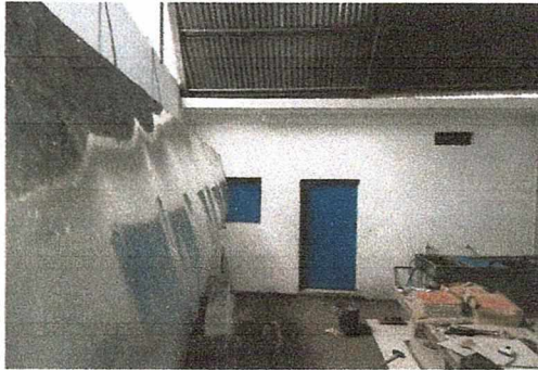
Foto 1: Bodega de cocina con techo de terraza y con su respectivo repello, con terraza para mayor seguridad.
