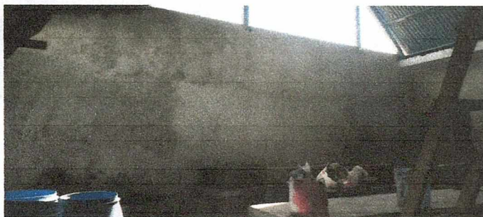
Foto 5: Muro que se levantó para mayor seguridad, porque no alcanzaba la altura del techo y se realiza el proceso del repello.
