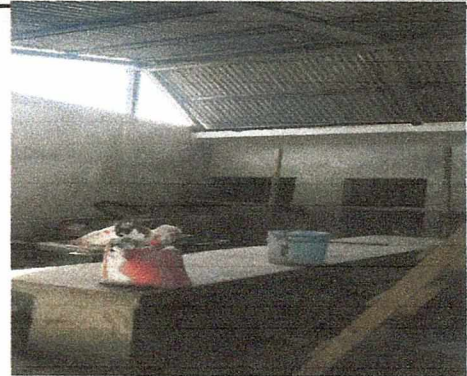
Foto 2: Área de cocina con muros altos por seguridad, el techo más alto para su mejor ventilación y claridad, en proceso de repello de las paredes.
