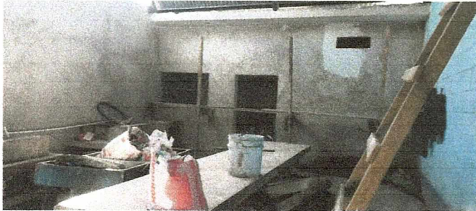
Foto 1: Bodega de cocina con techo de terraza y en proceso de repello, con terraza para mayor seguridad.
