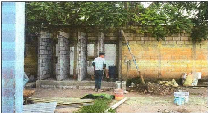
Foto1: Levantado de paredes de servicios sanitarios y cambio de tazas.
