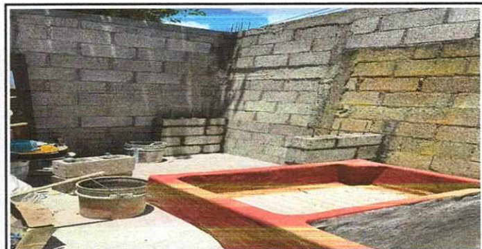
Foto 5: Remozamiento de poyeton en área cocina e instalación de pila.
