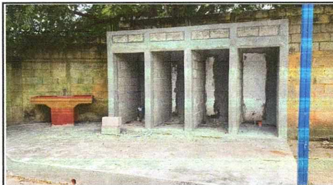
Foto 4: Construcción de banqueta en área de servicios sanitarios e instalación de pila.
