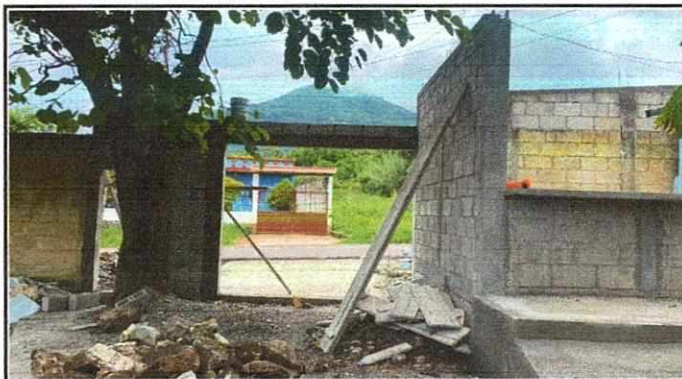
Foto 2: Levantado de paredes en muro perimetral y retiro de porton y puerta para remozamiento.
