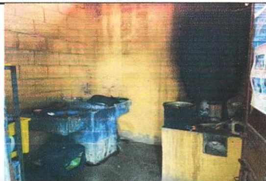
Foto 5: Interior de cocina donde se mejorará sistema de agua potable, drenaje y poyetón.
