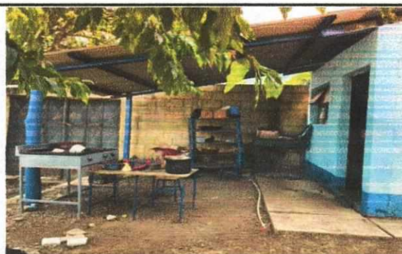
Foto 6: Exterior de cocina se elaborará piso de concreto y un desayunador.
