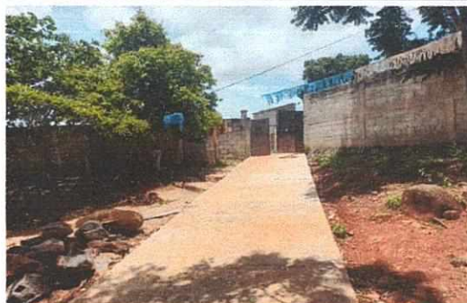
Foto 2: Rampa ya termianda, con porton pintado y nivelado.
