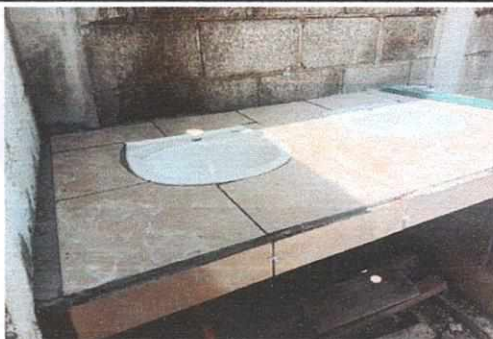
Foto 3: Area de lavado de manos ya terminada con azulejo y los lavamanos instalados.
