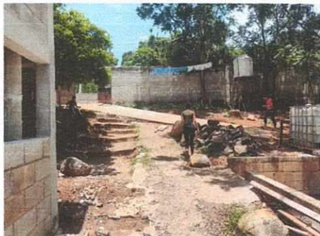
Foto 1: Rampa ya termianda, con porton pintado y nivelado.
