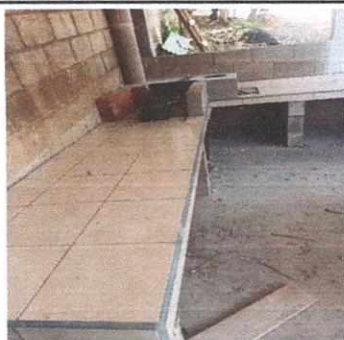
Foto 5: Mesones de cocina, azulejeados ya con las planchas y las chimeneas instaladas.
