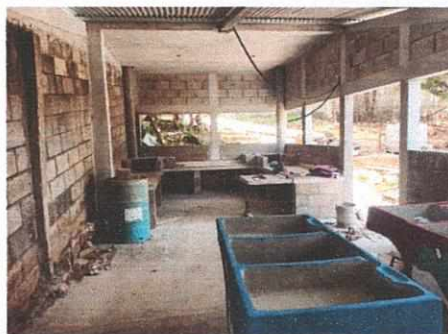
Foto 4: Interior de cocina ya concluido, solo falta acomodar las pilas.
