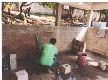
Foto 6: Inicio de trabajos en mesones donde iran los pollo fuegos dentro del area de cocina.
