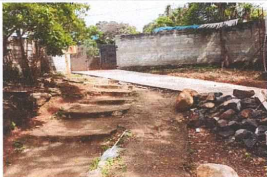
Foto 1: Ingreso principal con ya con la rampa fundida
