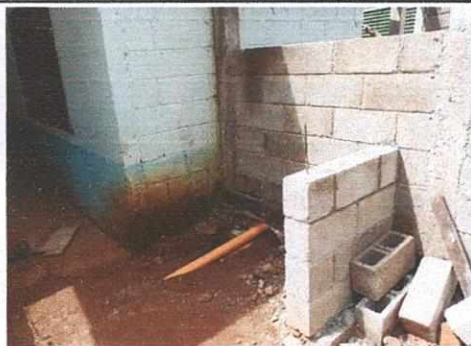
Foto 3: Muros de block para centar la fundicion donde iran instalados los lavamanos del area de lavado de manos.
