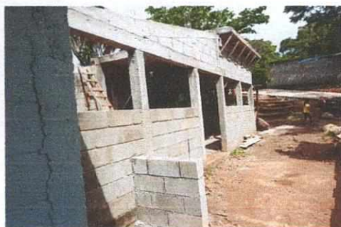
Foto 5: Parte del techo ya fundido con losa tradicional el resto se trabajara con estructura metalica
